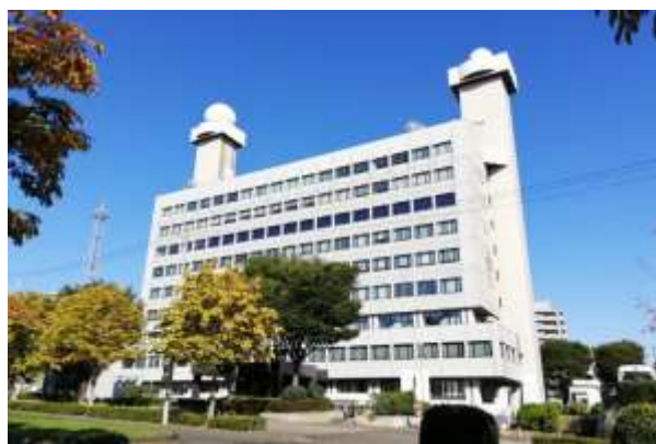
仙台第3合同庁舎外観
