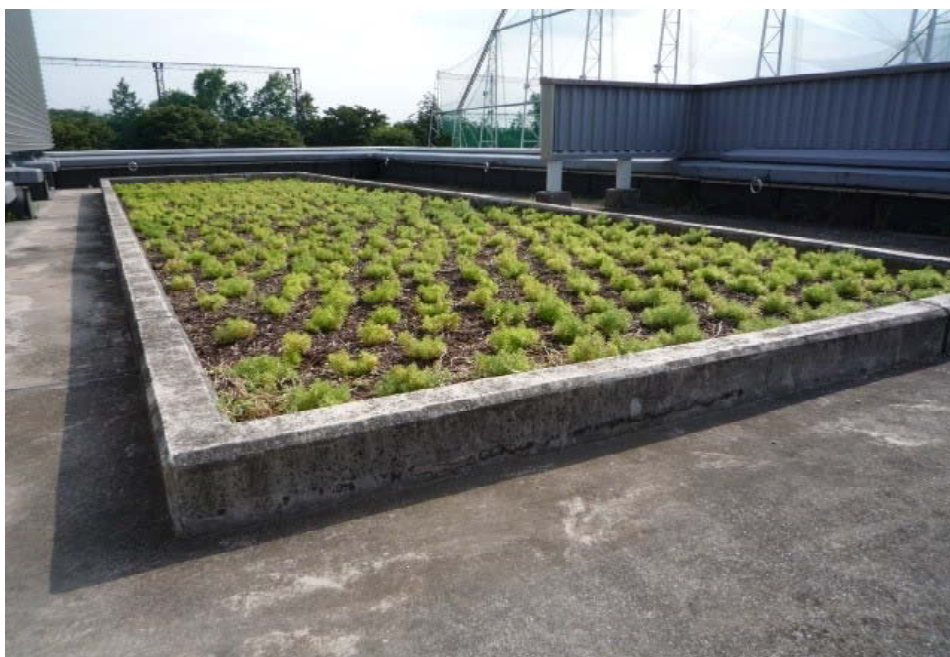
小平庁舎の屋上緑化
