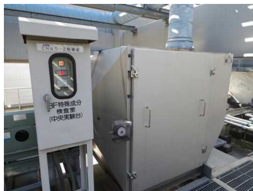
活性炭式脱臭装置 (乾式スクラバー)
