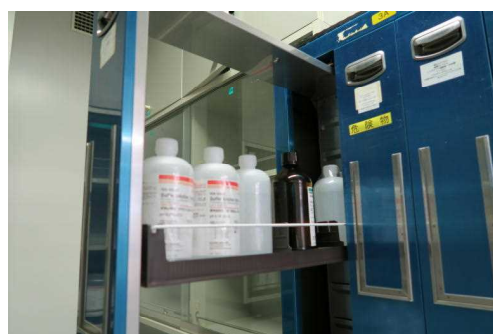
薬品保管庫内部
