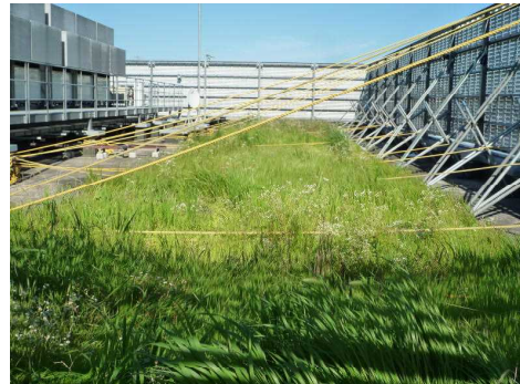
小平庁舎屋上②
