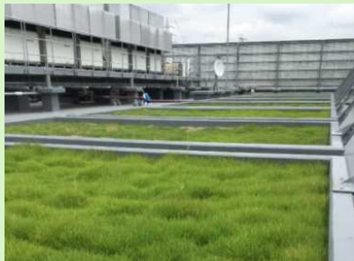
小平庁舎屋上
