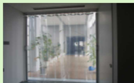
防風カーテン設置(小平庁舎)
