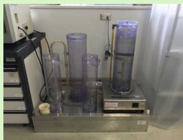
神戸（一般成分検査室 排水パン）
