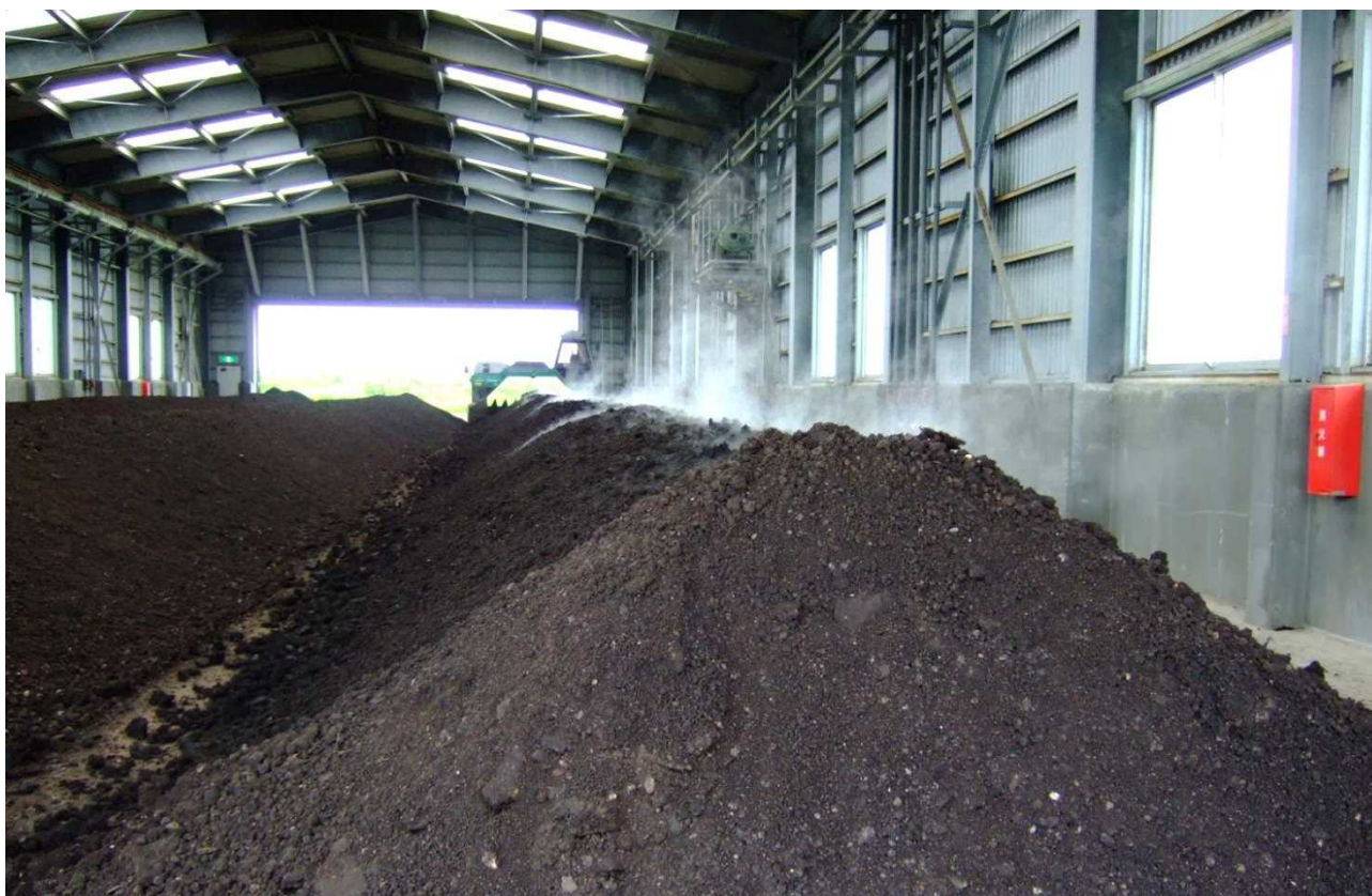
汚泥肥料の製品堆積場の様子
